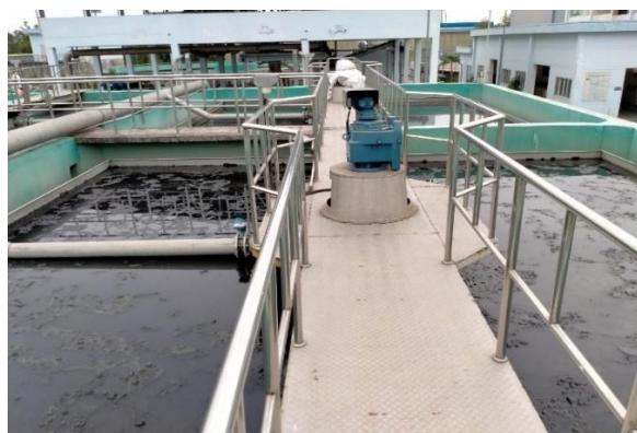
Hình 4.19. Bể nén bùn và cơ chế (Institute for Urban Water Management)
