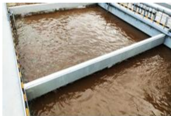
Hình 4.15. Bể Anoxic và cơ chế (Nutri-Systems International, Inc, 2004)
