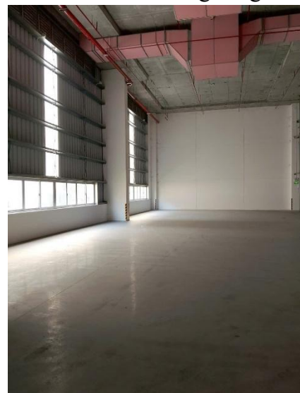
Khu vực tầng 2
