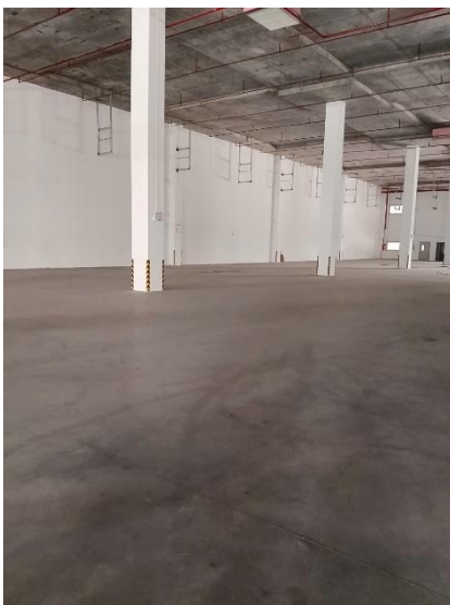
Khu vực Tầng 1
